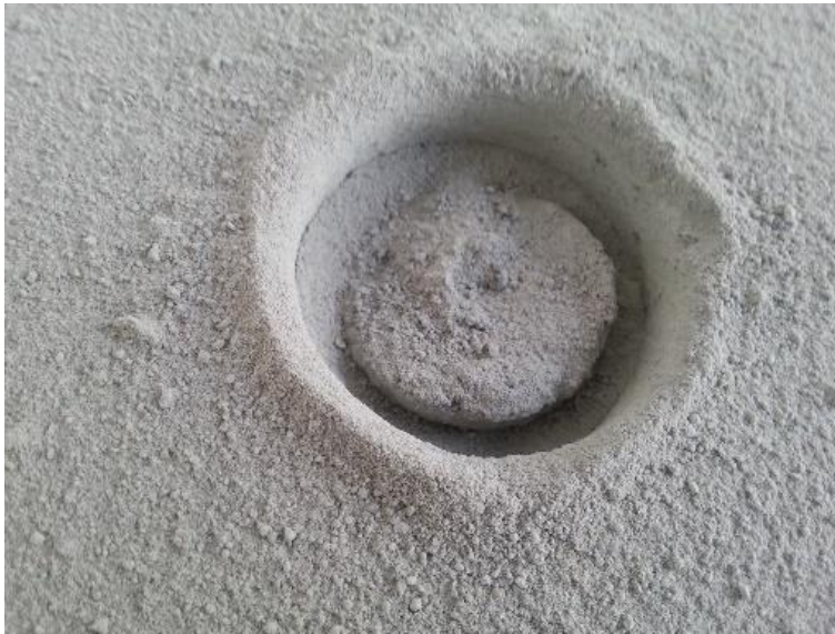
Fot. Nacięcie jastrychu do pomiaru pull-off wykaże, czy warto taki pomiar wykonywać
