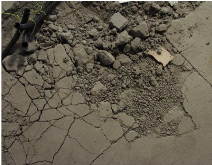
Fot. Żaden magiczny system nie scali i nie wzmocni takiego podkładu podłogowego
