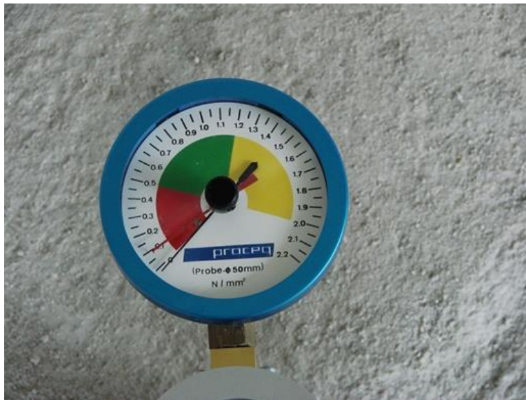
Fot. Niezgodny z normą, ale jedynie możliwy do przeprowadzenia, pomiar powierzchniowej przyczepności wykazał wytrzymałość na odrywanie 0,1 \text{ N/mm}^2 , co klasyfikuje jastrych do wymiany.
