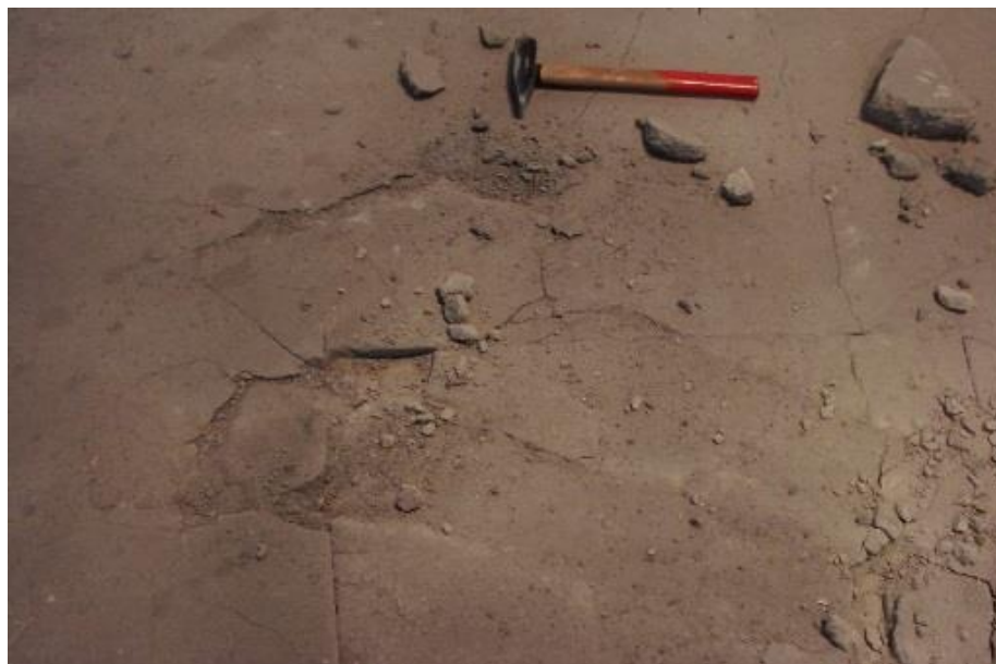
Fot. Nie zawsze trzeba używać sprzętu pomiarowego. Wystarczy zwykły młotek....
